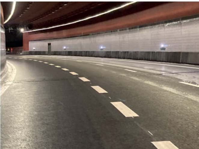
Mariefholmstunnel Göteborg Schweden
